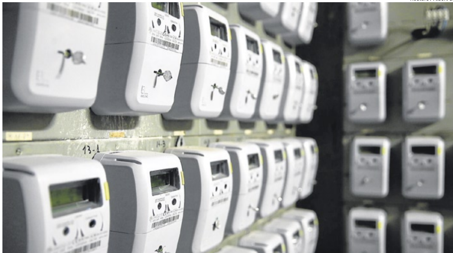
Contadores de luz. Aparatos para medir el consumo de electricidad en las casas de un edificio.
